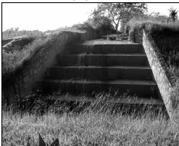
Figura 7 – escoamento da água pluvial com canalização de efluentes.
