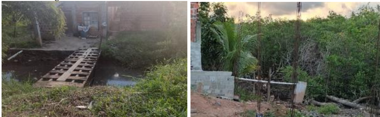
Painel 1– Esgotamento sanitário no bairro Teotônio Vilela
