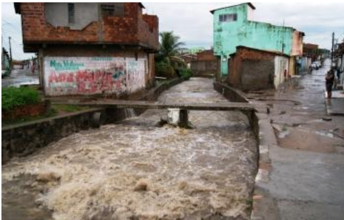
Foto 1- Residências próximas ao córrego no Conjunto Feira X-Feira de Santana 2020
