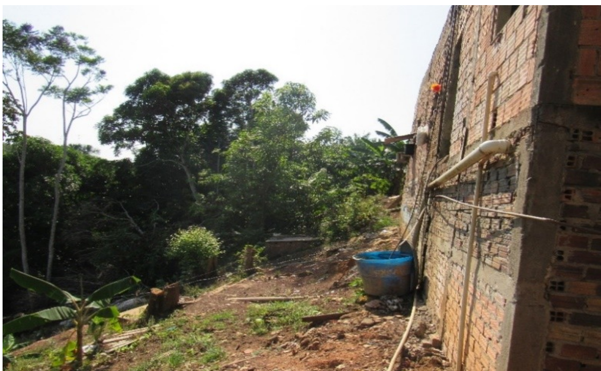
Foto 2 - Iranduba (AM): residência construída na encosta de declividade elevada.
