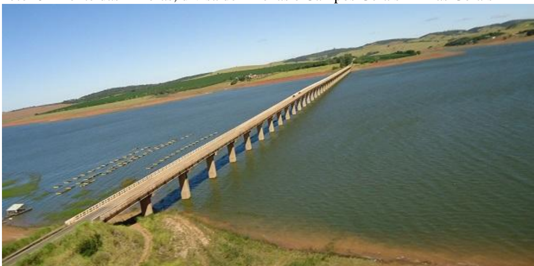
Foto 6 – Ponte das Amoras, divisa de Alfenas e Campos Gerais- Minas Gerais
