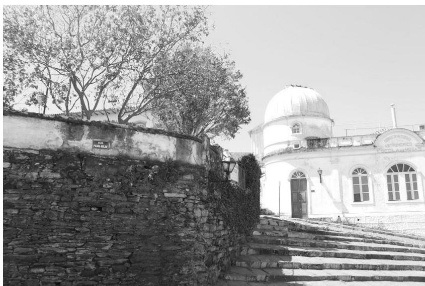
Figura 2: Prédio onde se localiza o Arquivo Permanente da Escola de Minas
