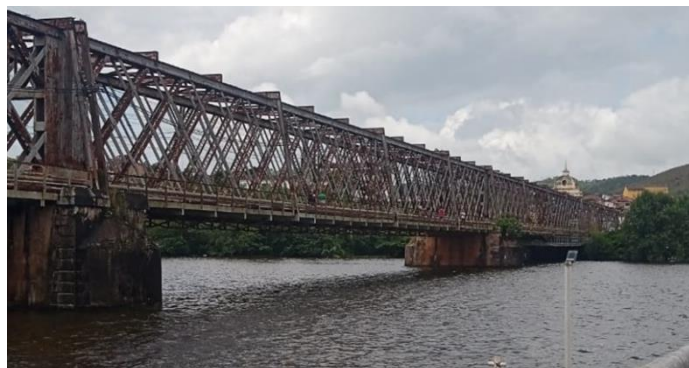
Figura 1 - Ponte D. Pedro II
