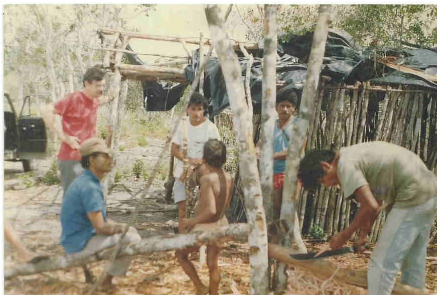
Construção do acampamento da retomada
