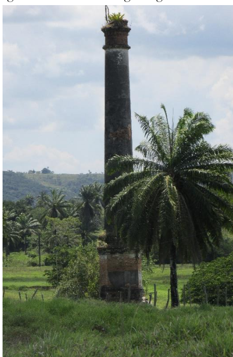
Figura 7 – Ruína do antigo Engenho da Cruz.
