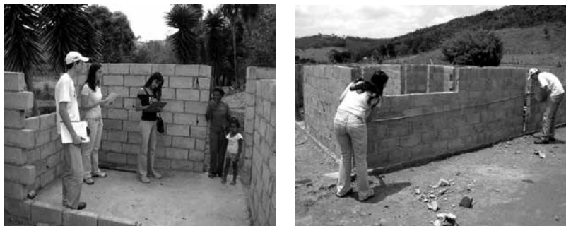
Figura 4 – Equipe de Vistorias – Realizando acompanhamento de construção.
