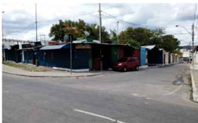
Figura 2 – Instalações provisórias da Feira do Paraguai
