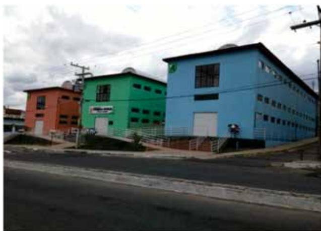
Figura 4 – Instalações provisórias da Feira do Paraguai
