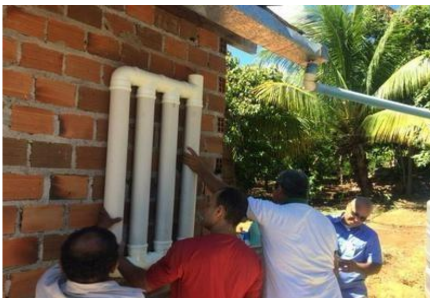
Figura 3: Oficina de construção e instalação dos desvios de água de chuva adaptado da UFPE
